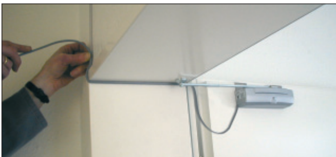
Beispiel 2: Das Anschlusskabel wird durch einen Kabelkanal am Türrahmen geführt.
